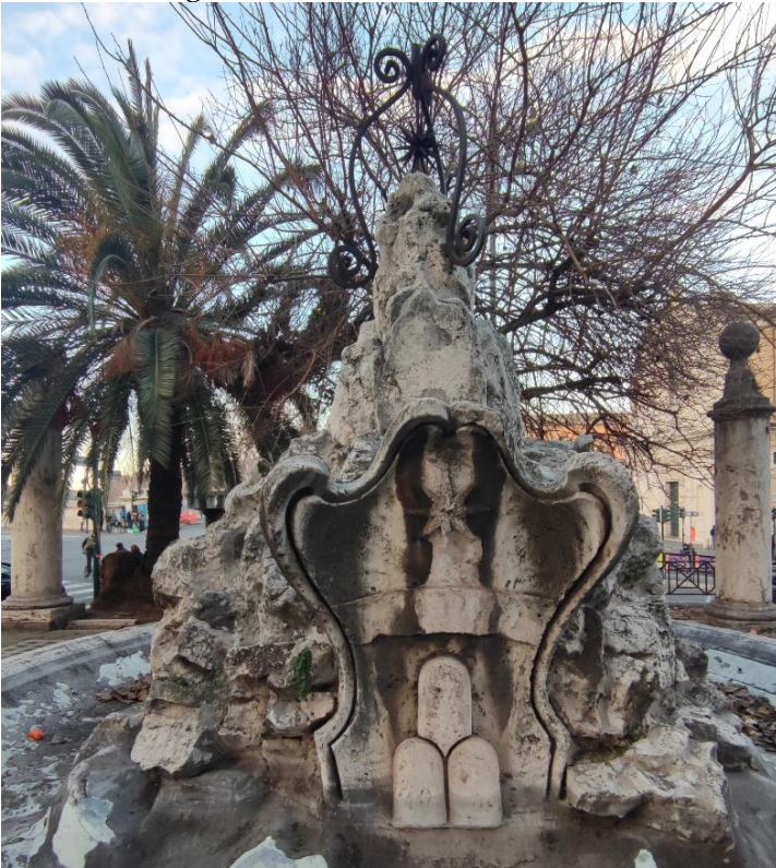
Fig. 4 La fontana com'era dal lato fiume. Dietro sono le 2 colonne.
